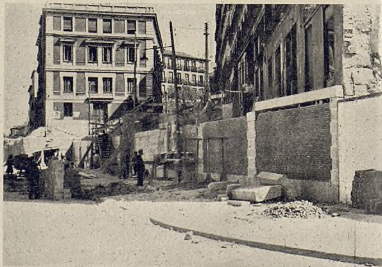
Efectuado ya el desmonte de las tierras en la calzada. Se aprecia el cambio de rasante.
