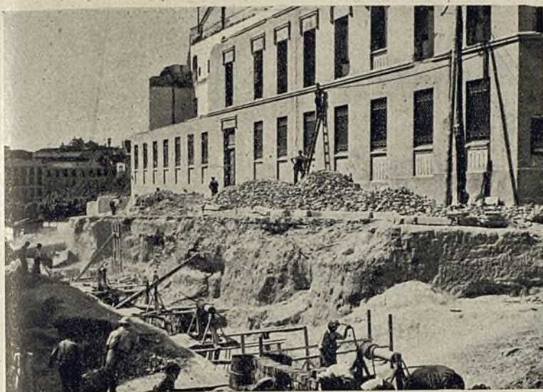
Desmante de terrenos y construcción de alcantarilla nueva.
