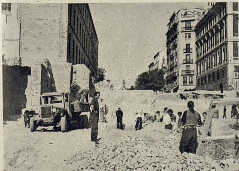
Desmante de tierras para cambio de rasantes.
