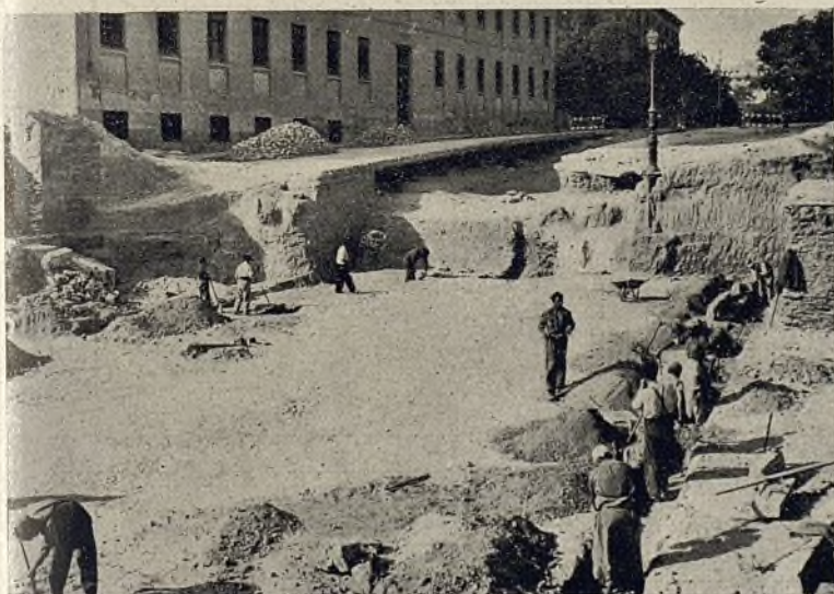
Desmante de tierras para cambio de rasantes.
