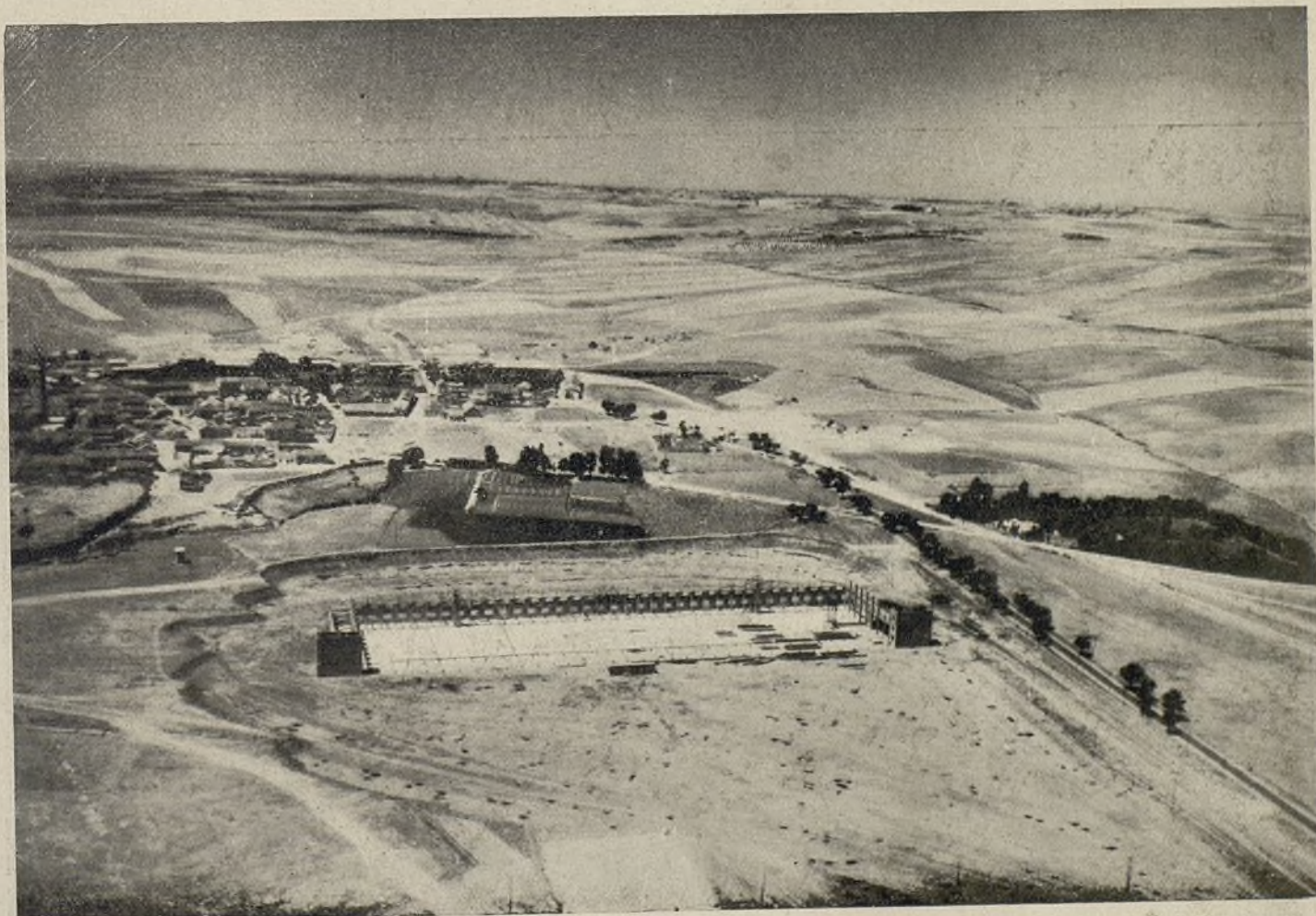
Hangar en construcción de 180 \times 47 \times 12,5 m.
