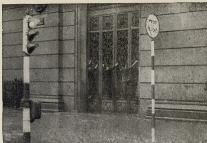
FIGURA 1.—Inundaciones de septiembre del año 1943. Pormenor del Banco de España.
