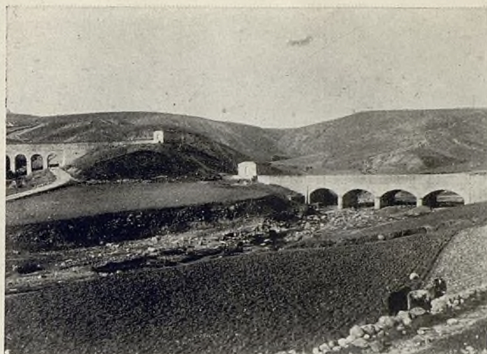
Canales de Lozoya. Obra de fábrica sobre el barranco del Mato y Canal del Guadalix. Al fondo, un desdrenador. A la derecha, bajada y sifón de Morenillo.
