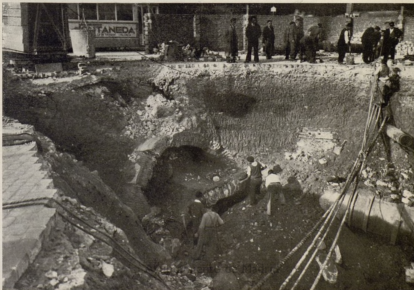
Hundimiento en la glorieta de Atocha. En la fotografía puede apreciarse el aspecto echadizo del terreno.
