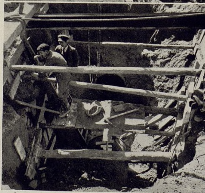
1. La tubería de 1.000 mm. de diámetro, al aire por descalce del terreno.—2. Calle de Orense. Rotura de tubería de 1.000 mm. con derrumbamiento de la cerca. 3. Calle de Orense. Hundimiento entibado, por mal terreno.
