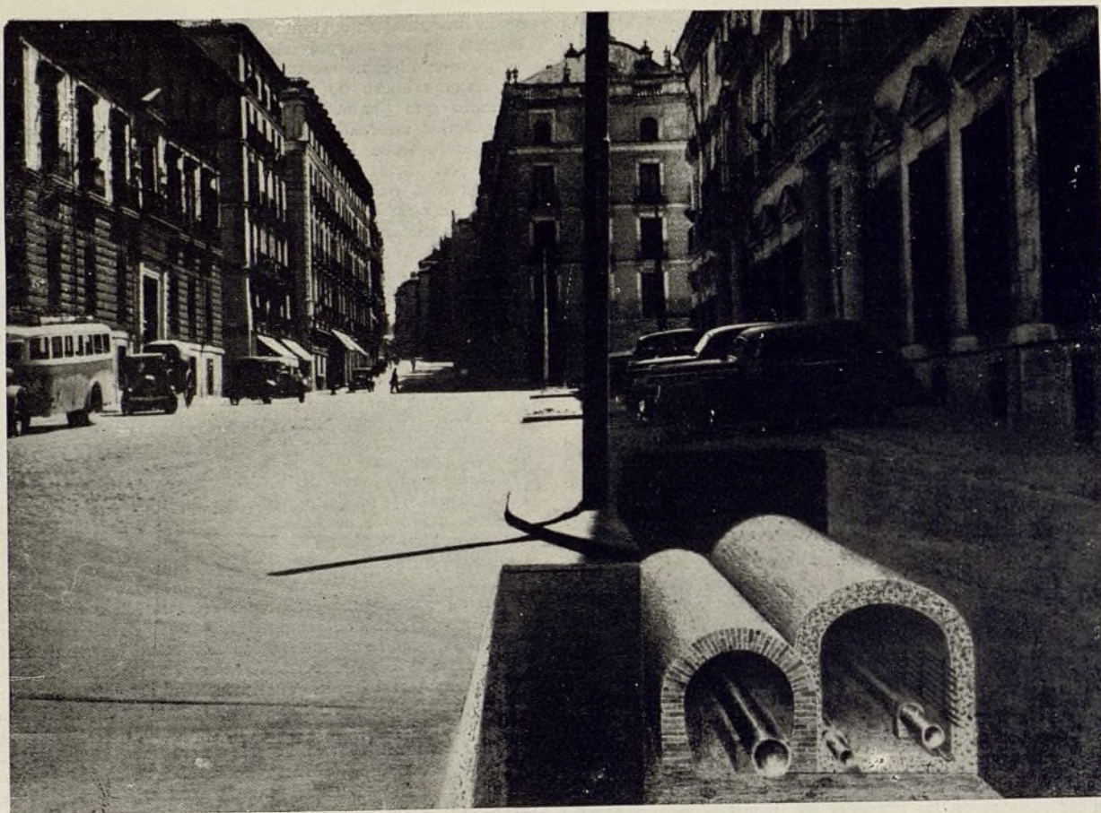
6-7 Fotos compuestas en la calle Mayor y en la calle de la Princesa del encaje de las galerías de servicios en el subsuelo de aquéllas.
