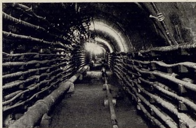
11 Galería de servicios en la calle de la Montera.
