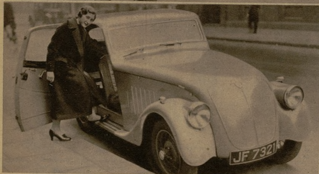
Este coche, que por su apariencia exterior no llama la atención, pues es un corriente y aerodinámico modelo moderno, ofrece la particularidad de no tener motor, en el sentido ordinariamente admitido. No tiene tampoco caja de cambios... No gasta gasolina ni aceite. Es "completamente eléctrico", y las potentes baterías que se ocultan bajo el "capot" se cargan durante la noche a muy poco costo (Fotos Vidal y Ortiz)
