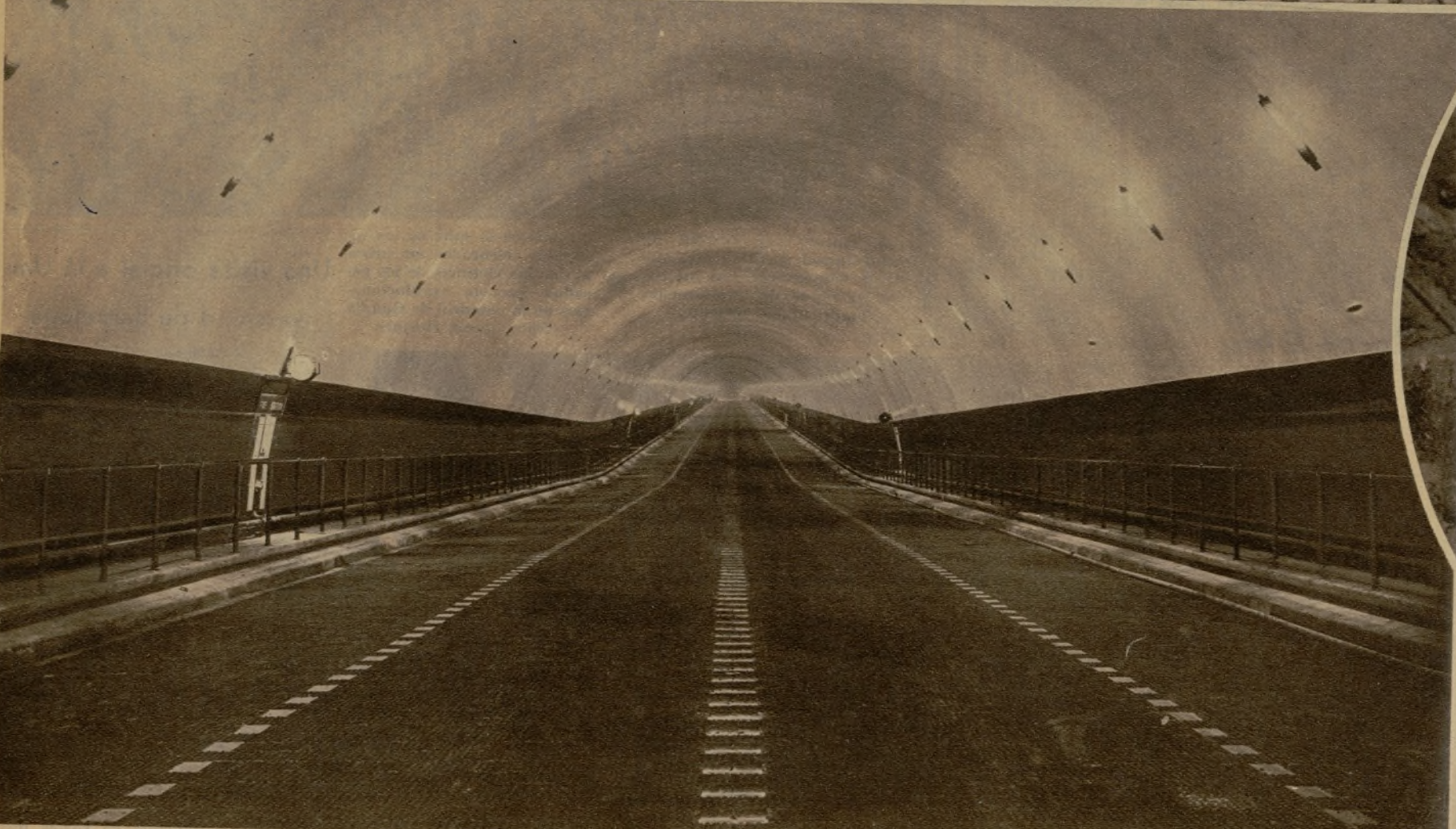
El túnel mayor del mundo se acaba de construir en Liverpool para unir la ciudad antigua con la nueva de Birkenhead. Tiene tres kilómetros y medio de largo y una anchura de catorce metros
