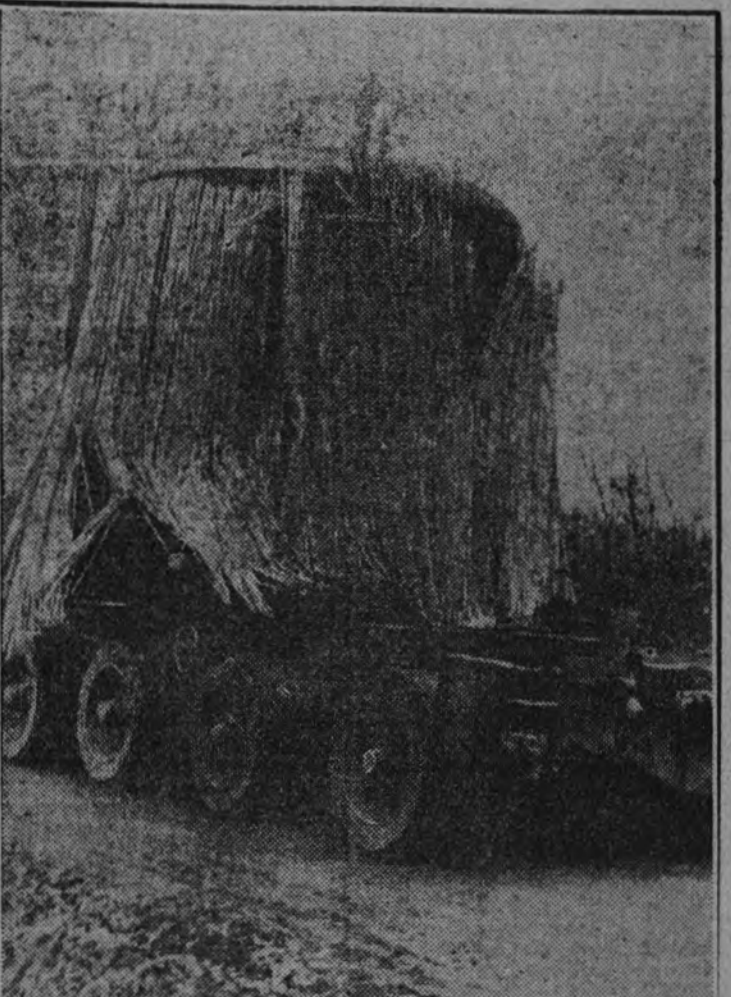
Un fortín alemán de acero montado sobre un remolque para su traslado al lugar en que será emplazado. El remolque es de construcción especial, pues la mole de acero pesa 150 toneladas.
