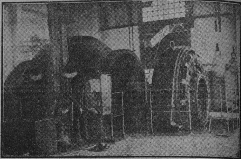
Tambor troncocónico, acoplado a un alternador de 350 kilovatios.
