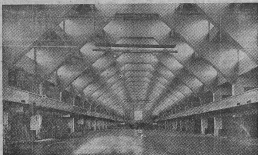
Ejemplo de cubierta con cerchas modernas de madera revestidas
