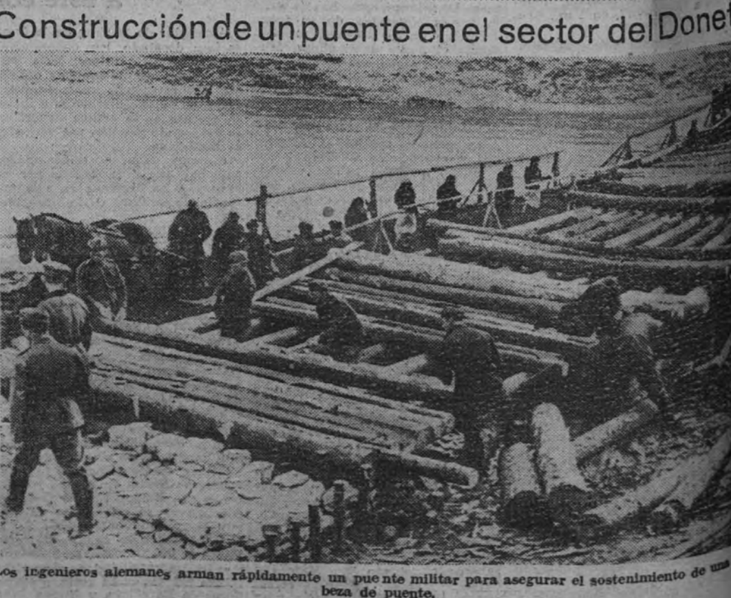
Los ingenieros alemanes, arman rápidamente un puente militar para asegurar el sostenimiento de una beza de puente.
