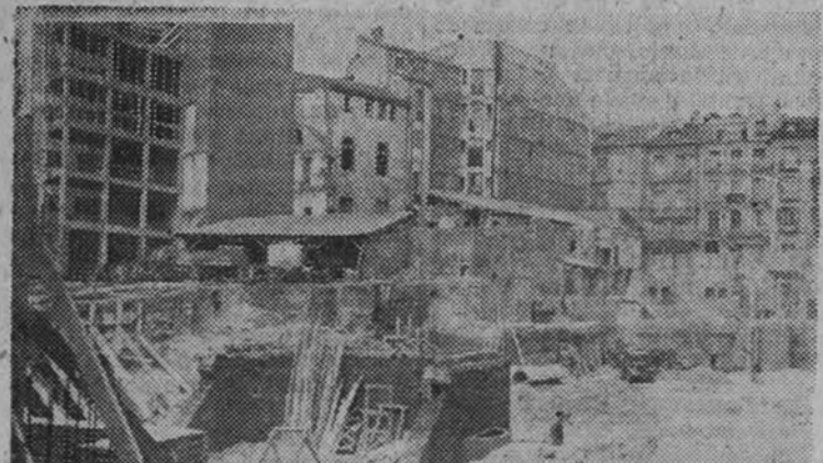
Hecho el vaciado en todo el perímetro del solar, avanzan las obras de cimentación.
