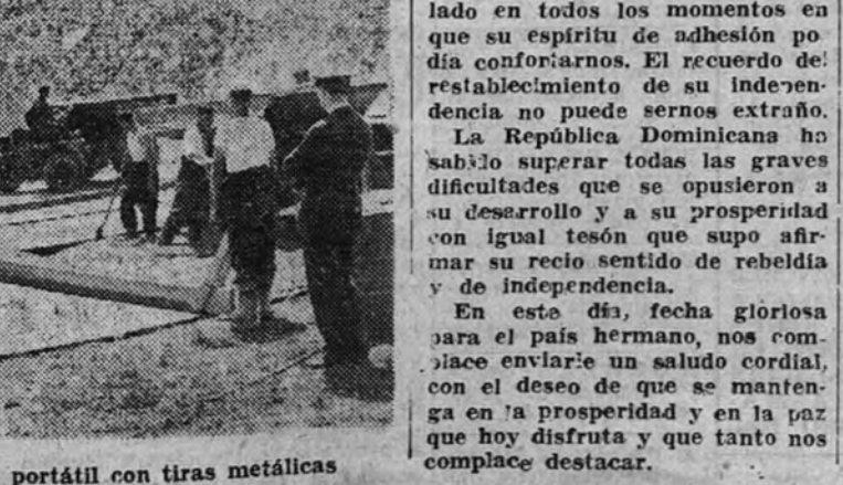
Construcción de un aeródromo portátil con tiras metálicas
