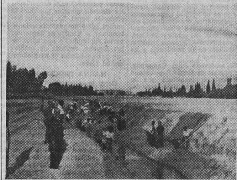
Zanjas realizadas en el lecho del río para el abastecimiento de agua a Salamanca
