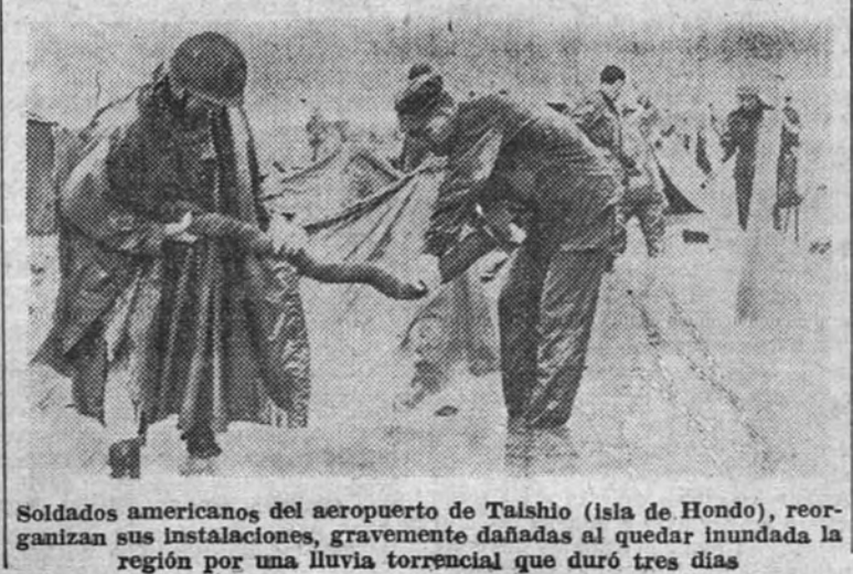
Soldados americanos, del aeropuerto de Taihio (Isla de Hondu), reorganizan sus instalaciones, gravemente dañadas al quedar inundada la región por una lluvia torrencial que duró tres días
