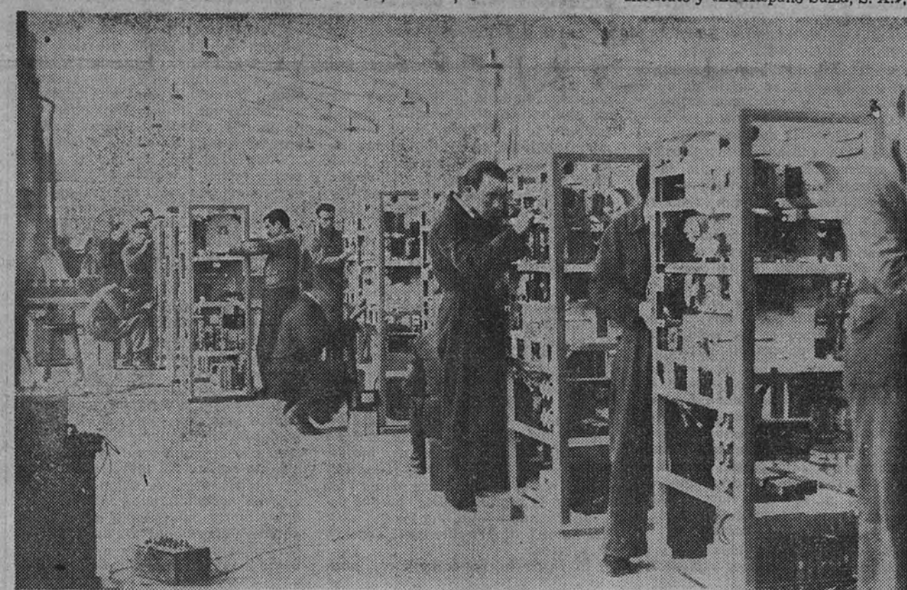
Taller de montajes de transmisores radioeléctricos, en Villaverde (Madrid), de «Marconi Española, S. A.
