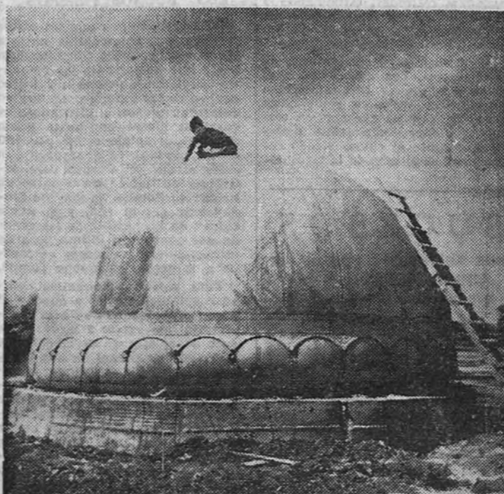
En las cercanías de Dakar se trata de resolver el problema de la vivienda con un nuevo sistema. Se trata de un globo, sobre el cual se echa una capa de cemento. Cuando ésta ha fraguado se desinfla el globo y queda la casa hecha en forma cilíndrica. La primera foto nos muestra el globo dispuesto para recibir el cemento. En la segunda, la casa terminada. (Foto Cifra.)
