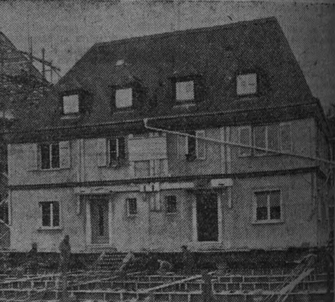
Para la construcción de un bloque de edificios, previsto en el plan de urbanización de la ciudad alemana de Erlangen, se tropezaba con el obstáculo de esta casa prefabricada de 635 toneladas. Los técnicos han resuelto el problema trasladando el edificio entero a un lugar situado a 125 metros de su emplazamiento primitivo. He aquí una fase de la operación que terminó con un éxito absoluto. (Foto Cifra.)
