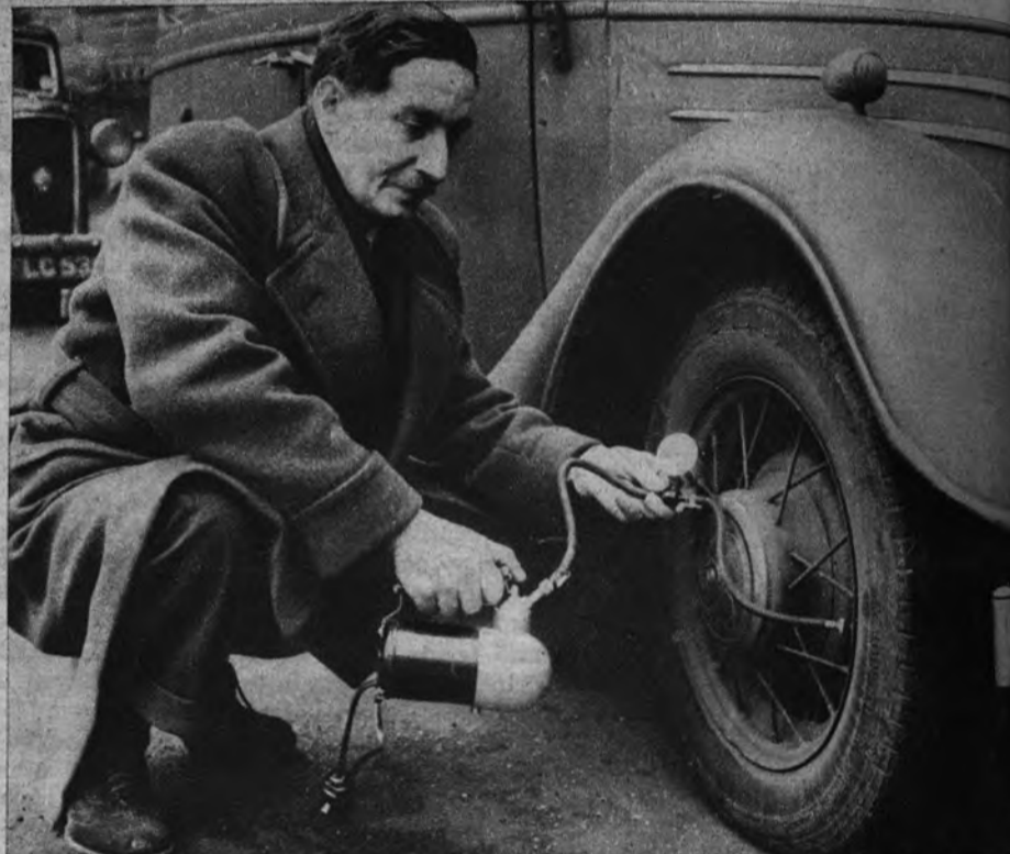
LA DICHOSA LEY DEL MENOR ESFUERZO. —Los automovilistas harán muy bien si consideran atentamente el nuevo dispositivo—un compresor de aire—que trabaja con la batería del coche. Es barato, se aplica desde dentro si se quiere y da aire suficiente para marchar libre de cuidados.—(Foto Cifra.)
