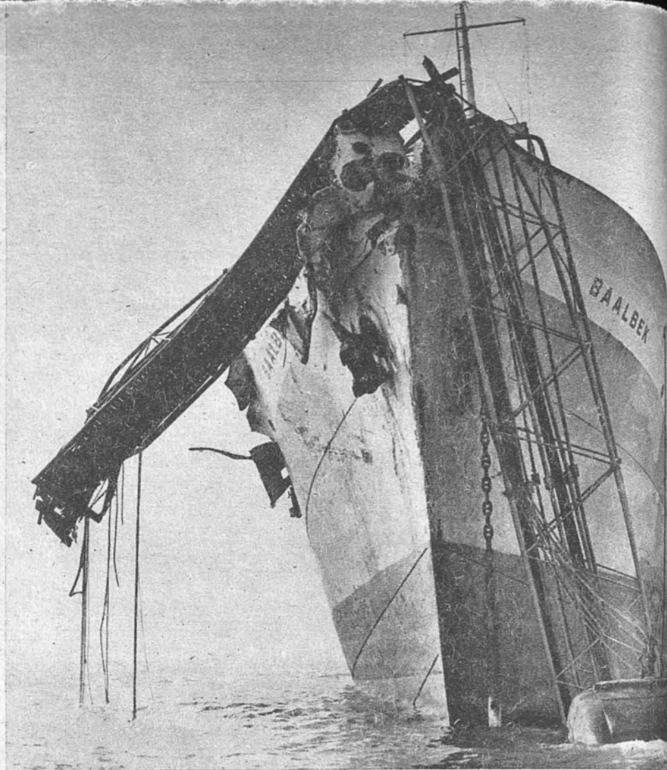
BUQUE AVERIADO EN UN CHOQUE. —He aquí el estado en que quedó el noruego «Baalbek», de 2.160 toneladas, después de haber chocado, a causa de la niebla, con una batería antiaérea en el estuario del Támesis. (Foto Nuño.)
