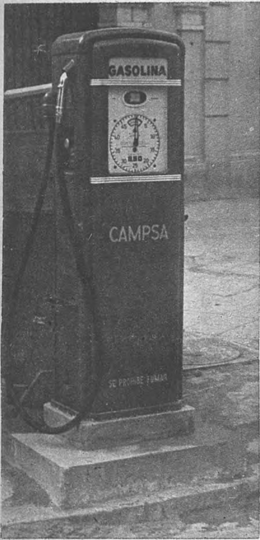
LA CAMPSA SE MODERNIZA. —Los surtidores de gasolina están siendo dotados de material moderno, eléctrico, automático, que a la vez que sirve marca la cantidad que tragó el depósito y el precio correspondiente. (Foto Leal.)
