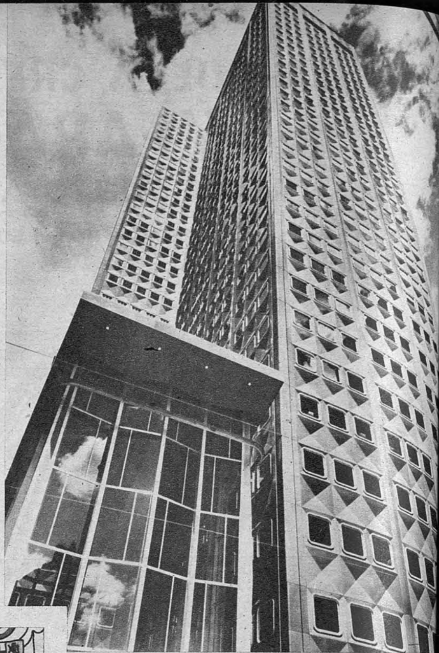
RASCACIELOS DE ALUMINIO. —La «Aluminium Corporation of America» ha construido para sede de sus oficinas en Pittsburg este rascacielos, que ofrece la particularidad de ser de aluminio precisamente. Tiene treinta y es el primer edificio de este tipo levantado en América.—(Foto Ortiz-I. N. P.)
