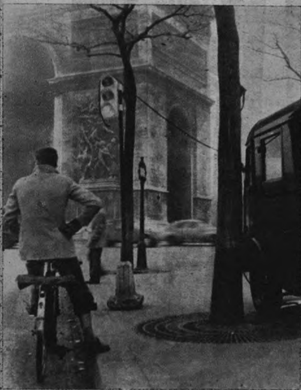
ENSAYO DE SEÑALES. —En torno a la plaza de la Estrella, el Ayuntamiento de París ensaya un sistema de señales móviles alimentado por un camión y unido sincrónicamente a otros postes.—(Foto De Miguel-Keystone.)
