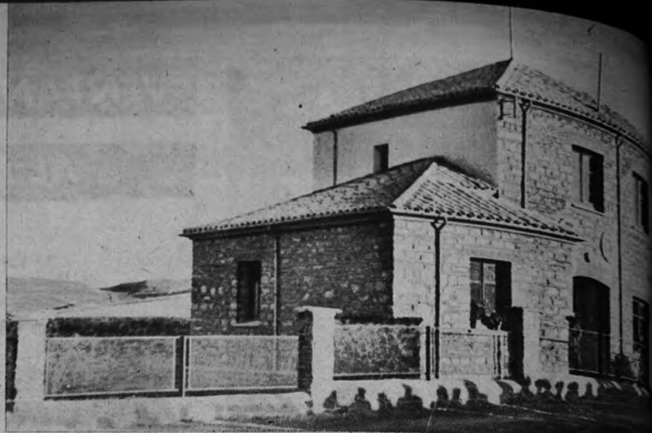
En Beltejar, humilde pueblo en la zona más desolada de la provincia, se alza, sólido y hermoso, este Centro de Higiene Rural, construido con el sacrificio personal del vecindario
