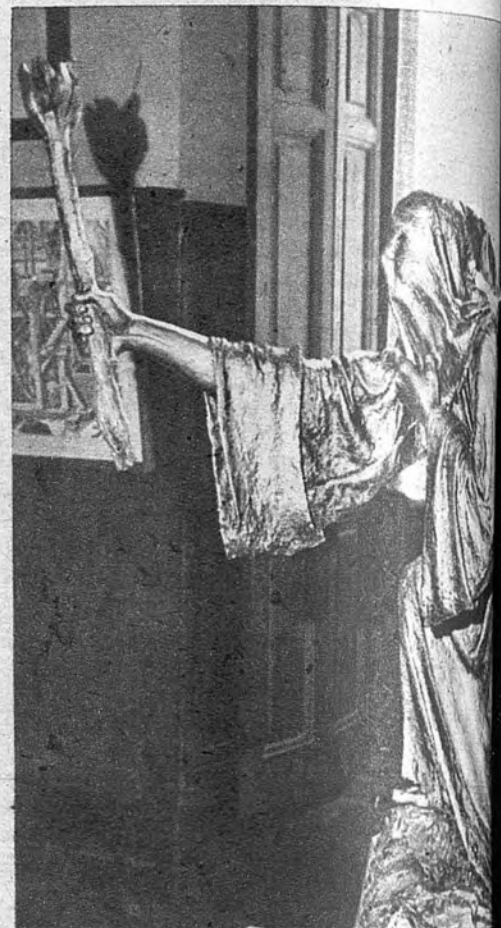
Este es el antiguo detector del grisú. Más de una vez habrá coincidido la comprobación de la existencia del gas peligroso con la última pirueta del atrevido «penitente»
