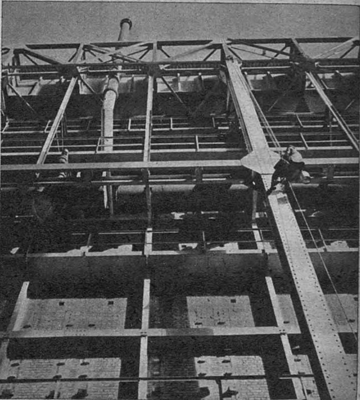
Mientras una batería de cincuenta y dos retortas se halla en pleno funcionamiento y otra gemela está a punto de utilización, se levanta ya otra nueva fase, a la que se dan los últimos toques del montaje (Fotos Aumente)
