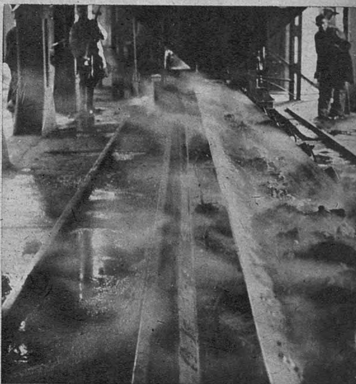
Tras el proceso de destilación, las escorias, aún a elevada temperatura, se extraen por la tolva inferior para su traslado a la escombrera
