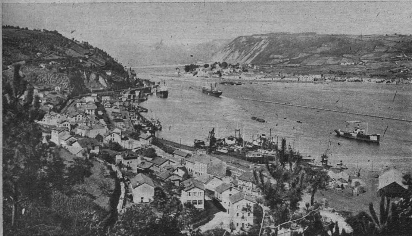
Vista general de la desembocadura del Nalón. A la izquierda, el pueblo y el puerto de San Esteban. En el centro, el espigón que le separa del cauce del río, al mismo tiempo primer trozo de la entrada al puerto. A la derecha, La Arena, por cuyo borde se quiere desviar la salida del Nalón hacia el mar
