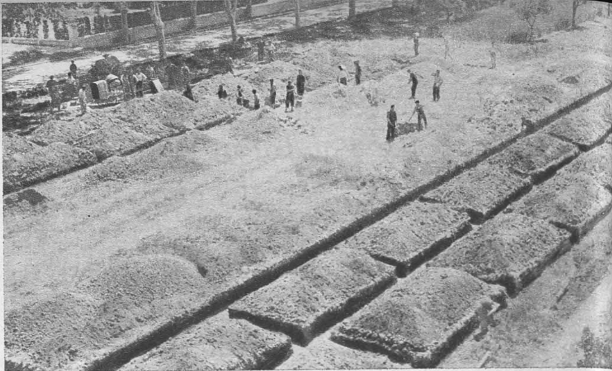
Estos son los cimientos del grupo de ciento cincuenta viviendas que, mediante prestación personal efectiva de sus beneficiarios—obreros y empleados de todas clases—, y bajo la oportuna dirección técnica, construye la Obra Social de la Falange de Tarragona
