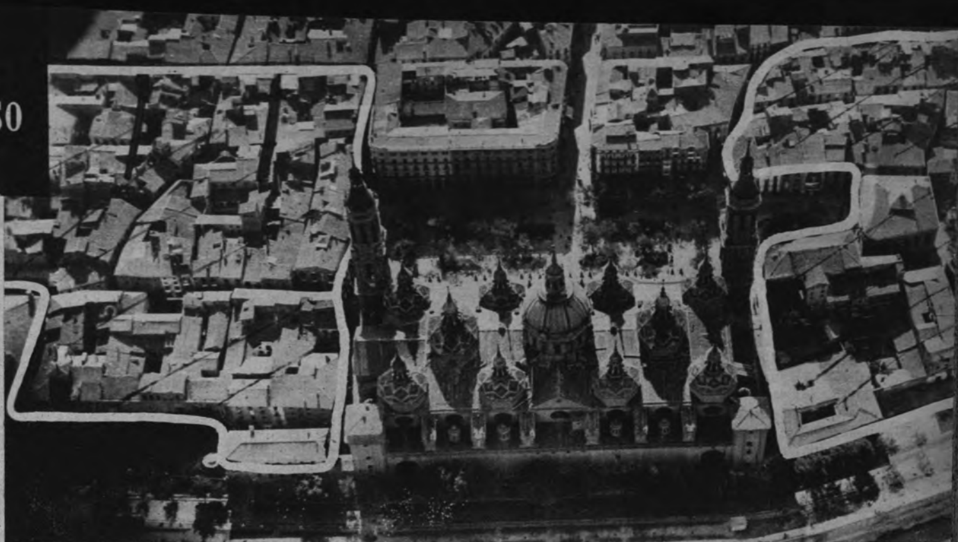
Panorámica del templo del Pilar. La fotografía es anterior al comienzo de las obras. En ella se advierten los grupos de inmuebles derribados (limitados por un trazo blanco) y el comienzo de lo que será prolongación del paseo de la Independencia
