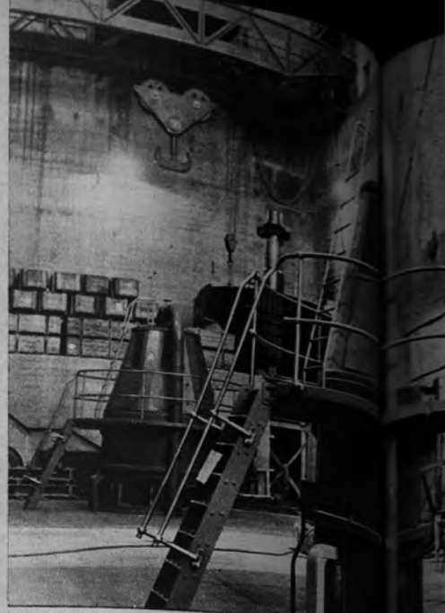
Estas son las dos excitatrices de los grupos que trabajan. En un rincón de la nave, y en plano superior, el rotor del grupo que se está montando. Debido a su enorme peso (250 toneladas) su instalación en el estator requiere el empleo de puentes-grúa. En la fotografía contigua, el parque de interruptores de línea en la subestación de distribución. A la derecha, el pupitre de mando de la sala de cuadros
