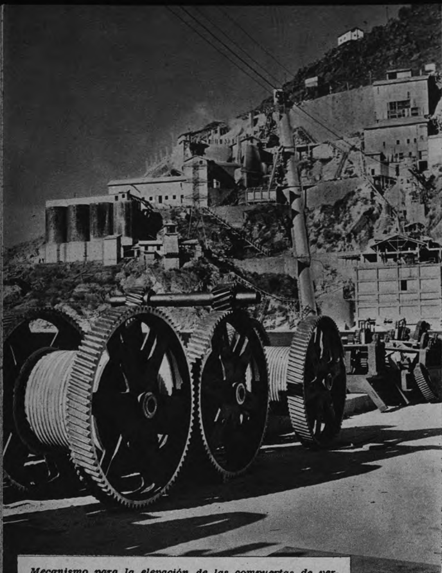
Mecanismo para la elevación de las compuertas de vertedero, que permitirán el desagüe de las máximas avenidas. Las compuertas serán cuatro, tipo Stoney, y terminarán de montarse a fines de octubre, lo que hará posible el aprovechamiento de las primeras lluvias otoñales. Al fondo está la instalación auxiliar de obra de tren machaqueo y molino del «clinker». El volumen total de hormigón empleado es de medio millón de metros cúbicos
