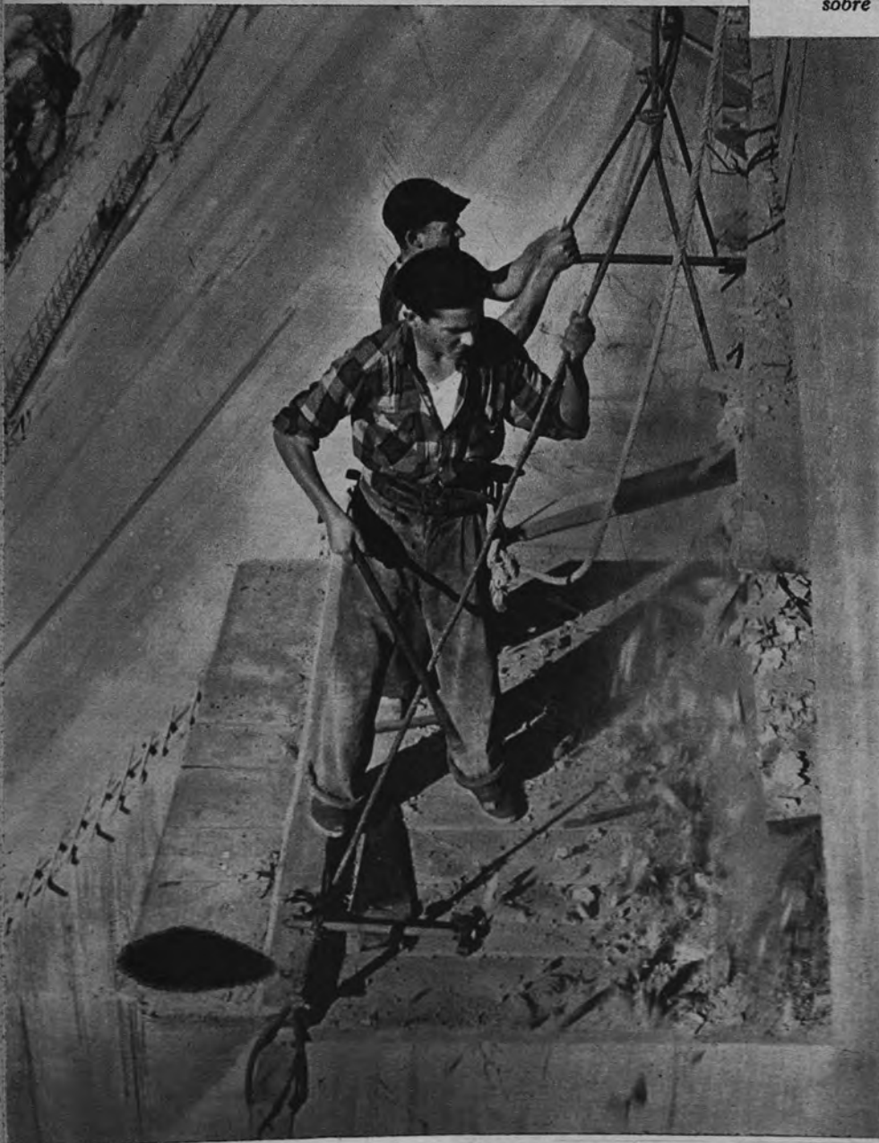
Mecanismo para la elevación de las compuertas de vertedero, que permitirán el desagüe de las máximas avenidas. Las compuertas serán cuatro, tipo Stoney, y terminarán de montarse a fines de octubre, lo que hará posible el aprovechamiento de las primeras lluvias otoñales. Al fondo está la instalación auxiliar de obra de tren machaqueo y molino del «clinker». El volumen total de hormigón empleado es de medio millón de metros cúbicos
