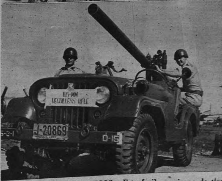
NUOVOS INGENIOS BELICOS. —Este fusil americano de tiro rápido es especial para combates nocturnos, y va provisto de un reflector infrarrojo. El cañoncito es de 105 milímetros, y no tiene retroceso, con lo cual, a bordo de un «jeep», transforma a este carrito en una nueva arma ofensiva capaz de grandes velocidades.—(Foto De Miguel Keystone.)
