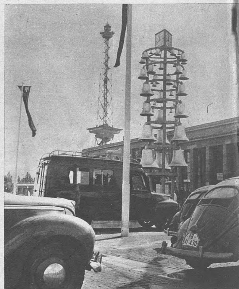
CAMPANARIO ELECTROMAGNETICO. —Este nuevo campanario es uno de los motivos más interesantes de la Feria Industrial de Berlín. Consta de 44 campanas, que suman un peso de nueve toneladas; las campanas están montadas sobre una estructura de acero y los badajos han sido sustituidos por elementos sonoros electromagnéticos.—(Foto Cifra.)
