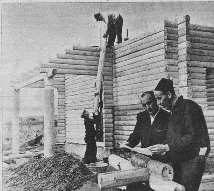
VIVIENDAS DE MADERA DE PINO. —Un constructor noruego ha logrado introducir en el mundo entero su sistema de construcción de viviendas en madera de pino. Las habitaciones pueden trasladarse fácilmente. Emplea en montar una casa cien pinos y un mes de trabajo.—(Foto De Miguel-Keystone.)
