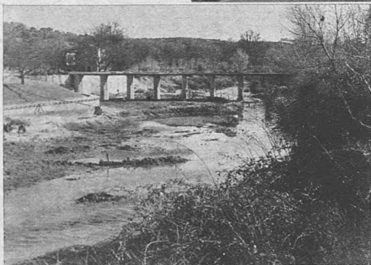
PRESA.—La presa que embalsará este diminuto mar domesticado cruza el cauce del Manzanares con sus impresionantes pilones de cemento, mientras el lugar de las compuertas permanece vacío aguardando su llegada (Fotos Pastor.)
