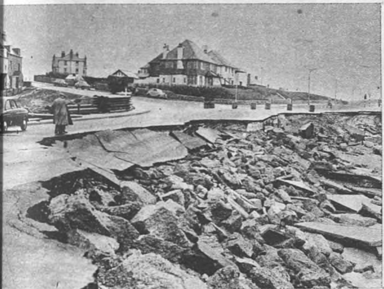
ESTO SI QUE ES UN SOCAVON. —La carretera principal y costera del condado de Sussex, Inglaterra, quedó cortada en parte—y de qué modo— a consecuencia de los últimos temporales, que acabaron, previamente, con los muros de contención que la protegen.—(Foto A. P.)
