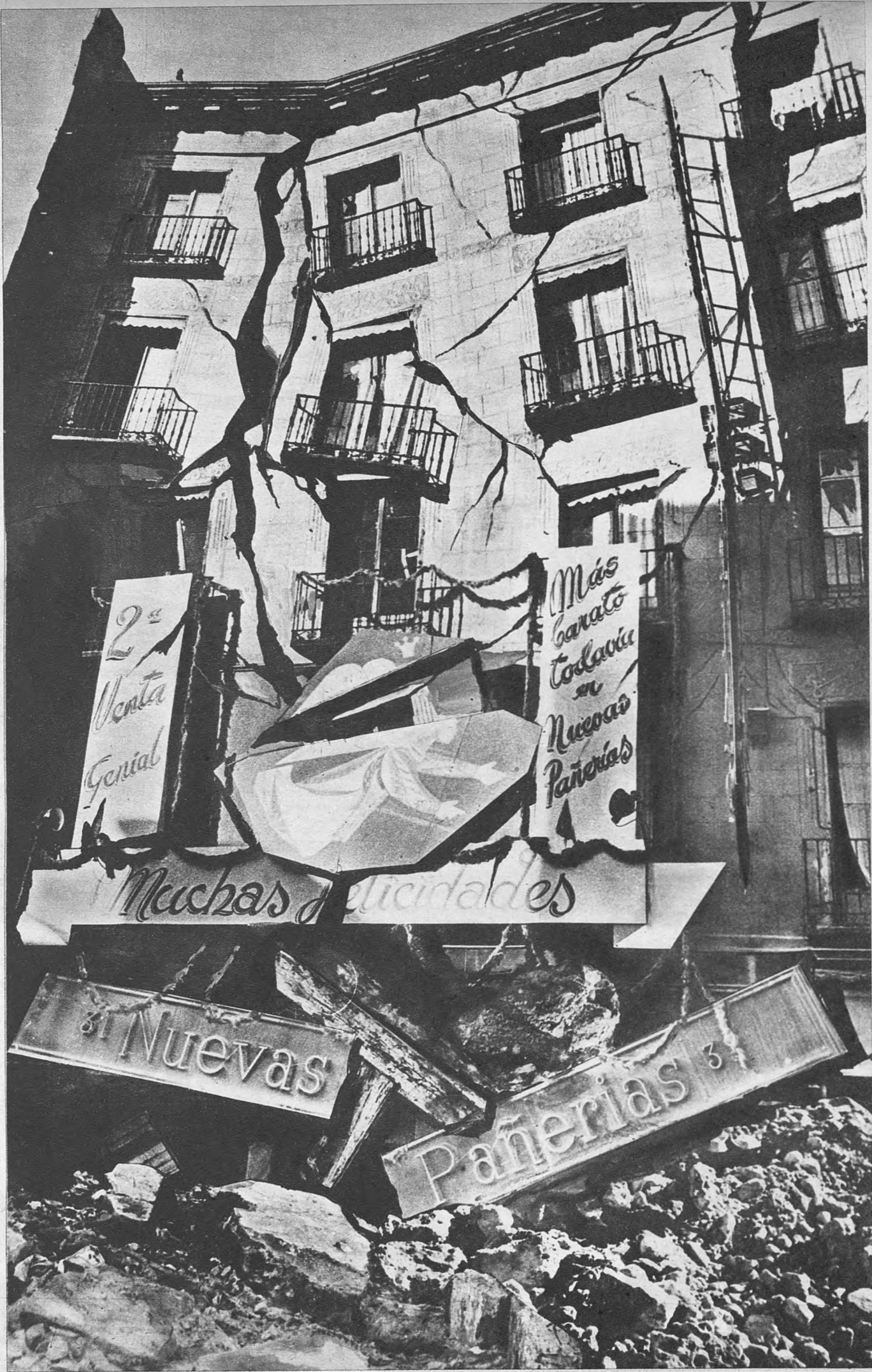
EL DERRUMBAMIENTO DE ESTA MADRUGADA.—Estado en que quedó la finca sita en la calle de la Montera, número 31, al derrumbarse sus muros, sin duda por el exceso de personas que acudieron a la VENTA que realizan los almacenes instalados en dicha finca.—(Foto Ventura.)
