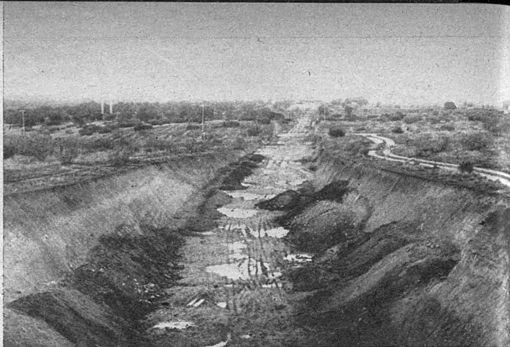
Esta perspectiva de la explanación del ferrocarril está tomada desde la carretera de Boadilla del Monte, y tiene una longitud de 1.500 metros hasta la salida del túnel que va desde la plaza de España a la estación del Lago de la Casa de Campo
