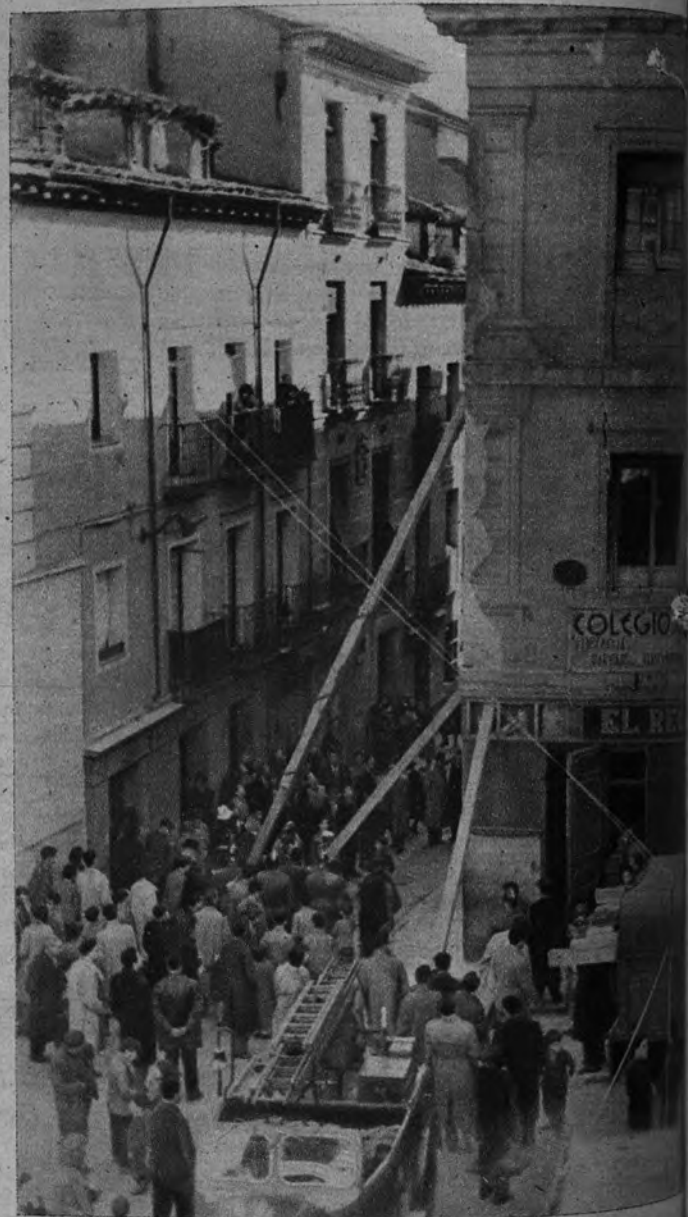
VIEJO MADRID. —El servicio de bomberos apuntaló urgentemente la finca número 52 de la calle de Mesón de Paredes, esquina a la plaza de Cabestros, que amenazó hundirse en la mañana de ayer. (Foto Cervera.)
