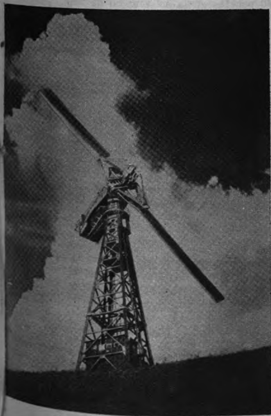
Aeromotor de 1.250 kw. instalado en Vermont (Estados Unidos)
