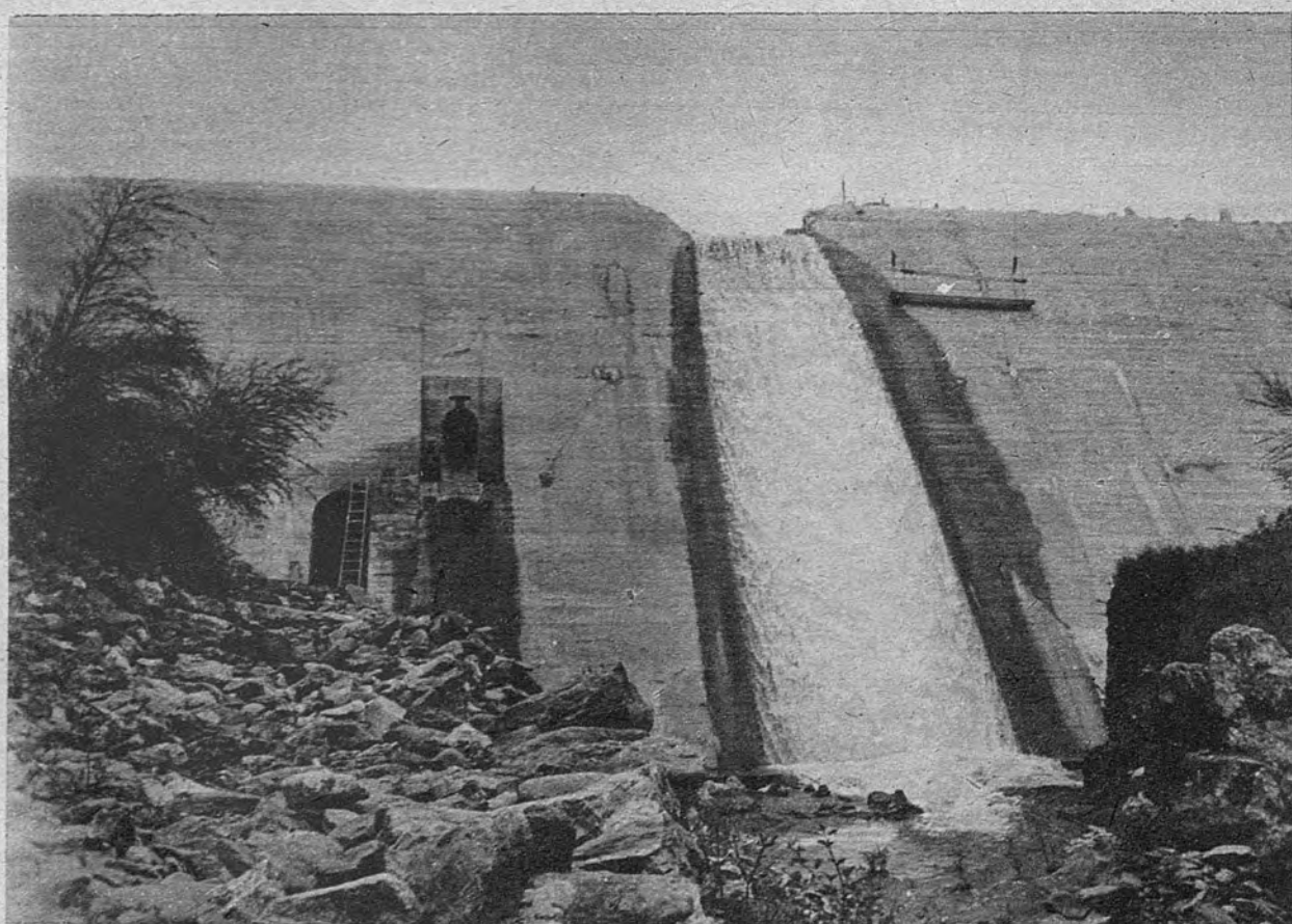
Este muro tendrá a la conclusión de las obras en curso una altura de veinticinco metros. En la foto se observa un sobradero provisional cuyo escape sería capaz de abastecer a la ciudad
