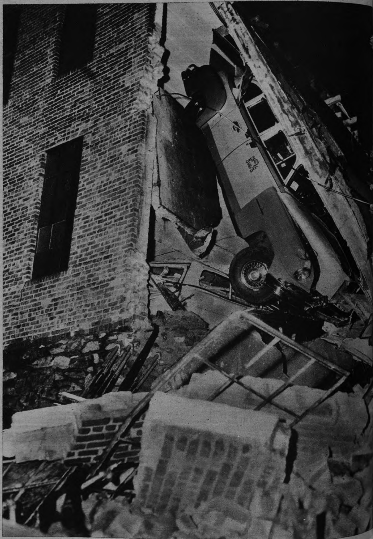
DESPRENDIMIENTO DE AUTOMOVILES. —A consecuencia de las recientes lluvias torrenciales se reblandecieron los cimientos de un importante garaje de Nueva York. El hundimiento del edificio, del que aquí vemos un aspecto, fué inmediato. Más de cien coches, guardados en dicho garaje, sufrieron desperfectos y quedaron en situaciones extrañas como la que registra la fotografía. Pereció entre los escombros un señor que estaba adquiriendo combustible en el momento preciso del hundimiento. — (Foto Ortiz-I. N. P.)
