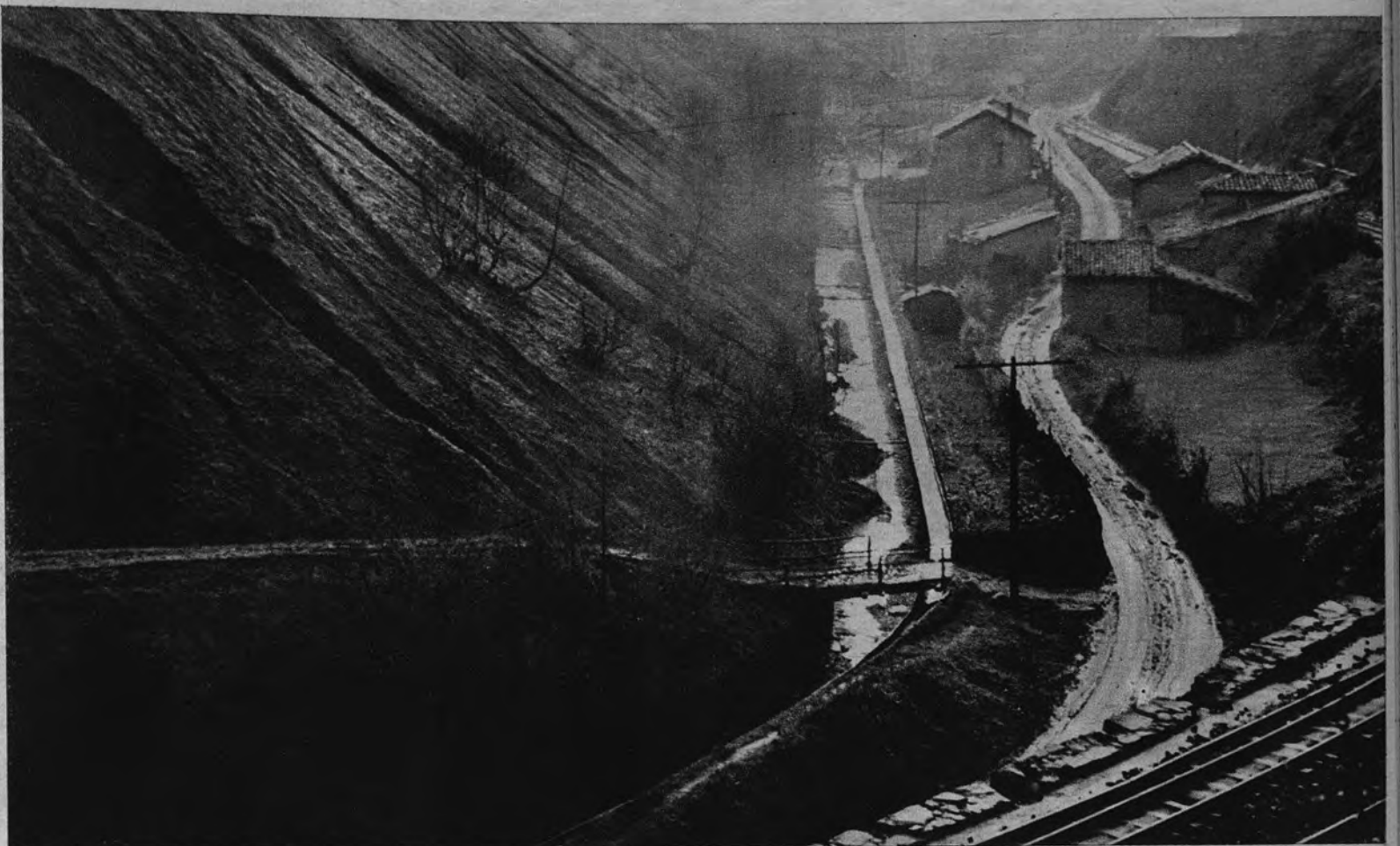
Esa inmersa masa negra de la izquierda es una amenazante escombrera sobre el río San Juan, de Mieres. El río, ya bien aplastado, socavará, cuando llueva, la base de la escombrera. La inundación será inevitable.
