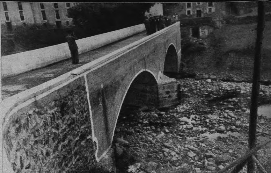
Regiones Devastadas realizó en Guipúzcoa diversas obras para reparar los daños causados por las inundaciones. Este puente sustituye a otro arrastrado por las riadas
