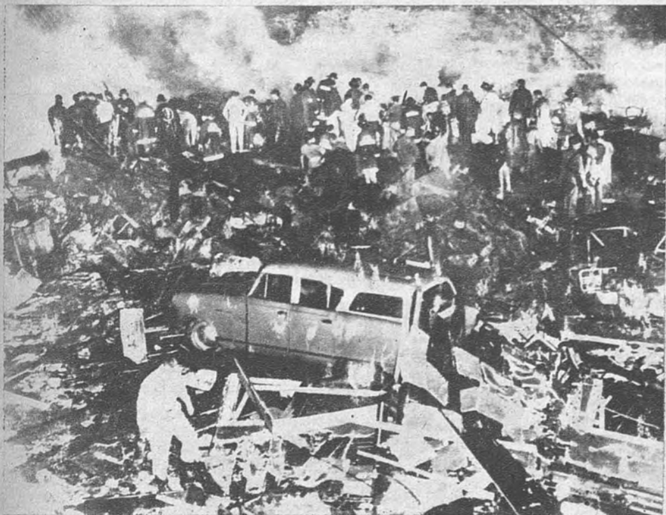
EDIFICIO DESTRUIDO POR UNA EXPLOSION. —La foto nos da idea de la magnitud de esta catástrofe, ocurrida en Andover (Ohio). Equipos de socorro buscan entre las ruinas de un edificio destruido por una explosión los restos de las víctimas.—(Foto Ortiz.)
