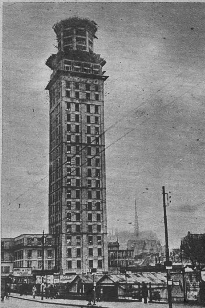
EL RASCACIELOS MAS ALTO DE EUROPA. —Este rascacielos está construyéndose en Amiens. Consta de treinta pisos y alcanza una altura de ciento cuatro metros. El inmueble pesará ocho mil toneladas
