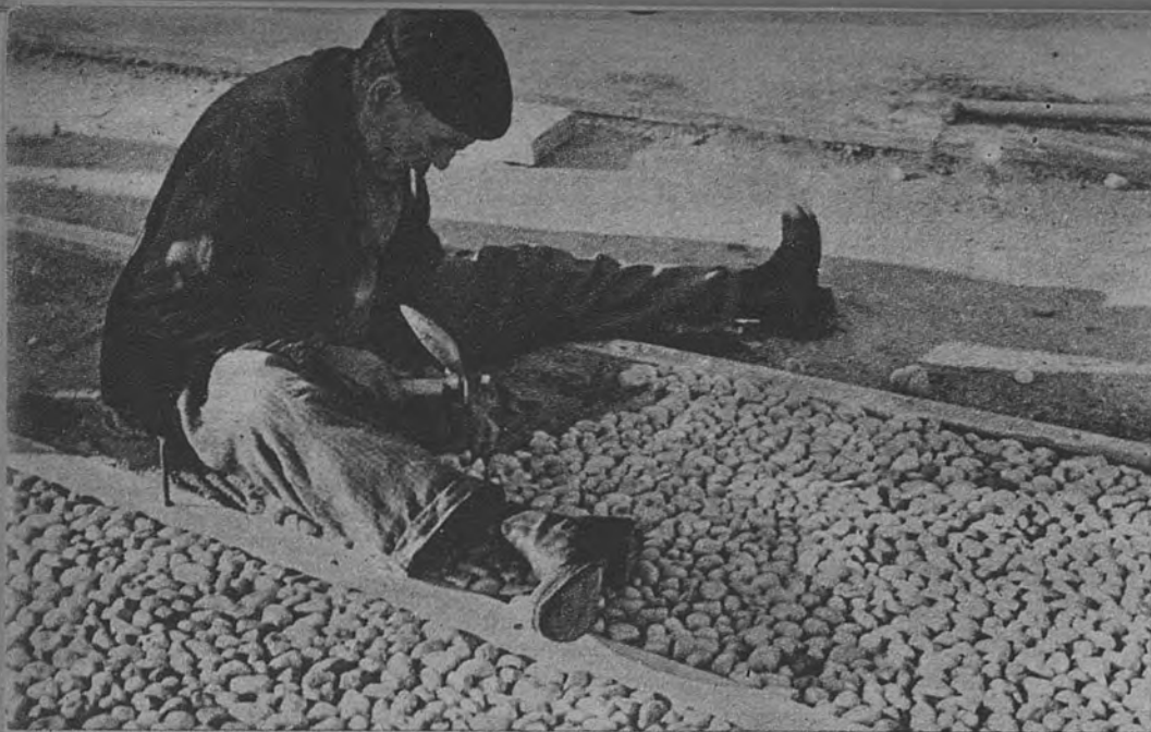
PAVIMENTACION ARTISTICA. — Guijarro a guijarro, venciendo cada problema que presentan la variación de tamaño y forma, este obrero va construyendo, entre la admirada contemplación popular, uno de los nuevos pavimentos que ostentará el espléndido paseo del Prado
