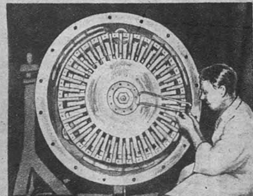
Condensador rotativo que genera la corriente de frecuencia modulada necesaria para el funcionamiento del ciclotrón de la Universidad de California.
