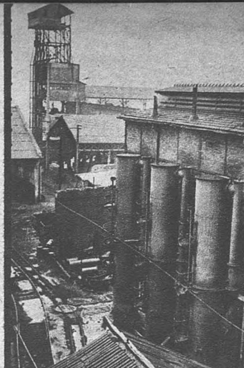
2 El combustible para esa calefacción es un gas de inferior calidad, que se produce en esta instalación auxiliar de la derecha. Al fondo, una clasificadora de cok.
