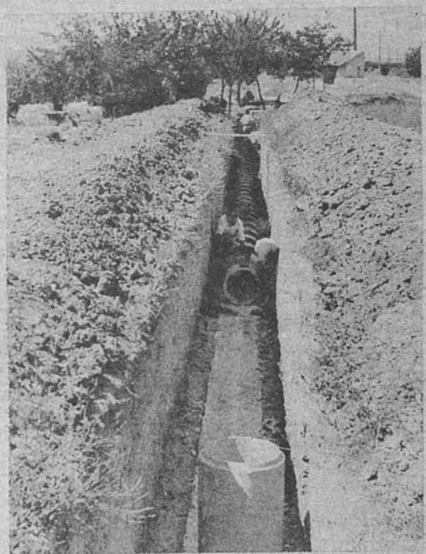
Se trabaja sin descanso en la entubación en las zanjas dispuestas y preparadas ya en todas direcciones, como se aprecia en esta foto.
