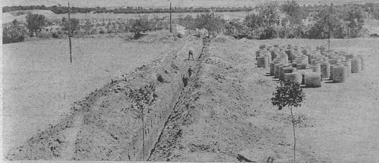
En esta vista panorámica se ven al pie de las zanjas los tubos que los obreros han de colocar en la que aquí se reproduce.
