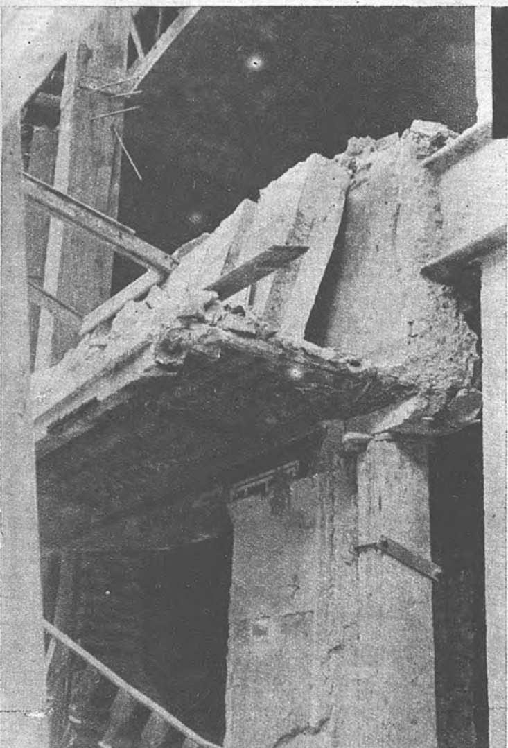
CONSTRUCCION NEGLIGENTE. —La fotografía corresponde al reciente hundimiento producido en una casa que se construye en Barcelona. Dos obreros muertos es el trágico balance de este accidente, por desgracia tan repetido, que exige la adopción de severas medidas de carácter general.—(Foto Cifra.)
