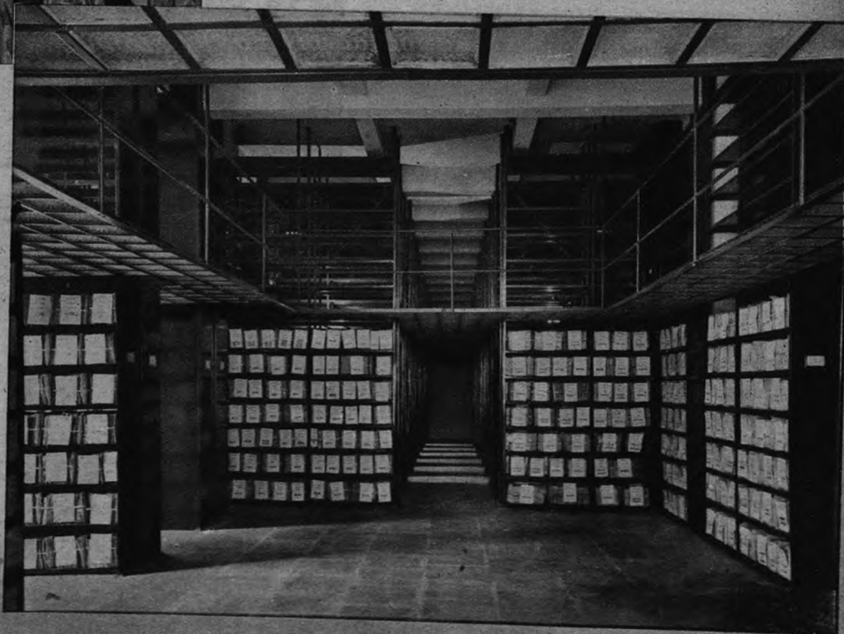
Vista parcial de una de las alas de la planta primera. Obsérvese el entresuelo metálico con losetas de cristal.
